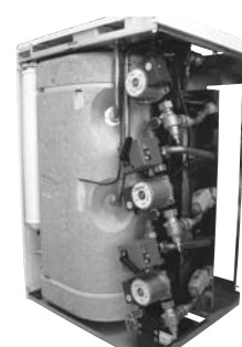
Fig. 3 - Configurazione a tre zone (una Diretta e due Miscelate)
