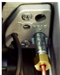
Regolazione testa di combustione
